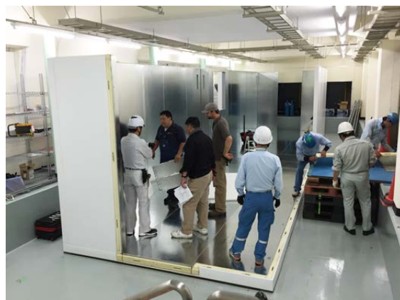
ロボット式フリーザーを組み立てる作業員
