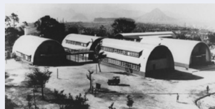
完成した比治山の研究施設
